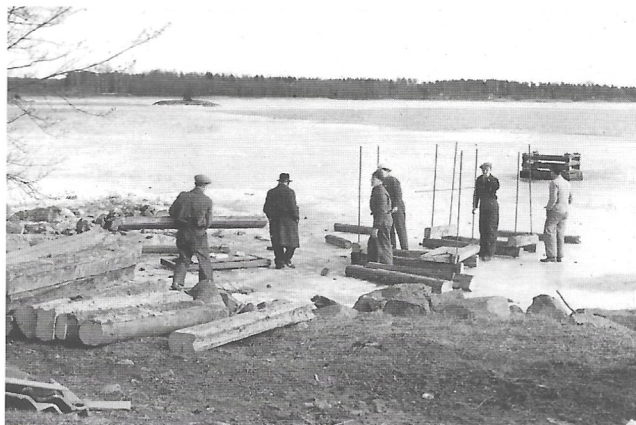
I avtalet med fastighetsägaren ingick skyldighet att bygga en brygga. Här jobbar bl.a Åke Carlsson, A F Gustafsson, Sune Gustafsson, Gunnar Essenholm och Gunnar Erlandsson med att bygga stenkistor.
