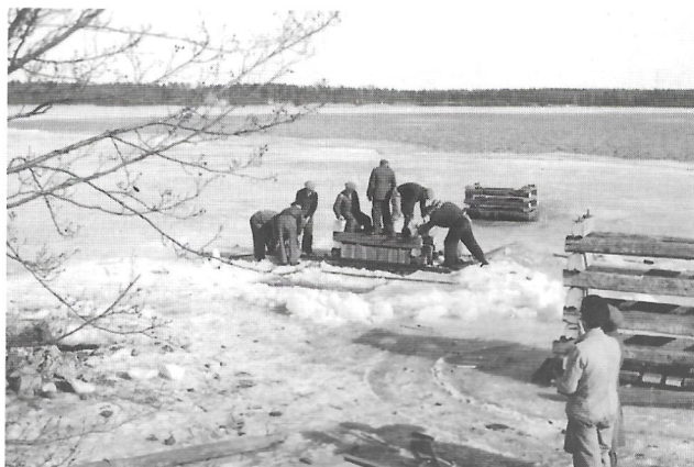
I avtalet med fastighetsägaren ingick skyldighet att bygga en brygga. Här jobbar bl.a Åke Carlsson, A F Gustafsson, Sune Gustafsson, Gunnar Essenholm och Gunnar Erlandsson med att bygga stenkistor.
