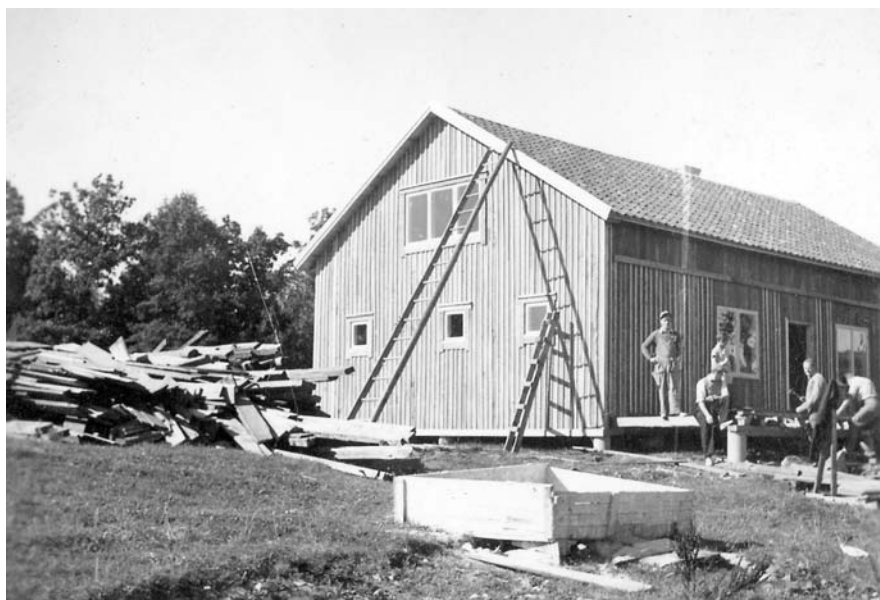
Klubbhuset i Sikhall under uppförande
